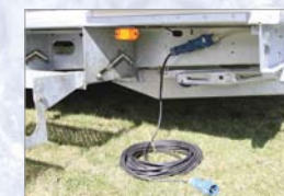
Stromanschluss 230 V / 16 A mit Verlängerungskabel
