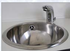
Wasserhähne mit Sensorautomatik
